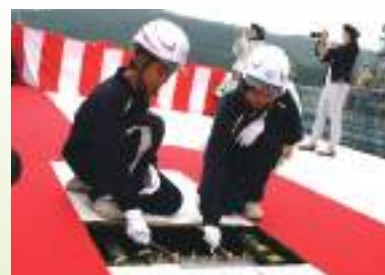
▲ 「古口大橋」ボルト締結式
