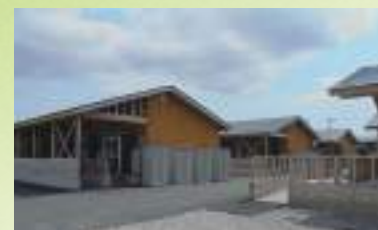
▲ 応急仮設住宅建設
