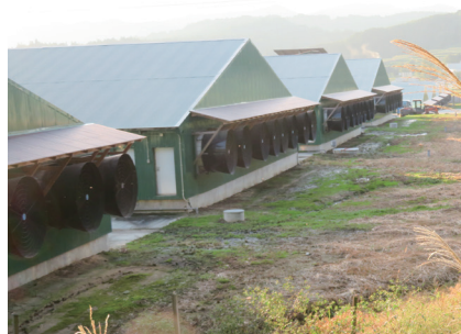
戸沢ファーム排気ダクト
