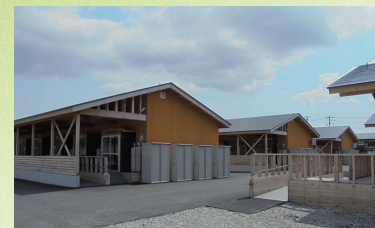
▲ 応急仮設住宅建設
