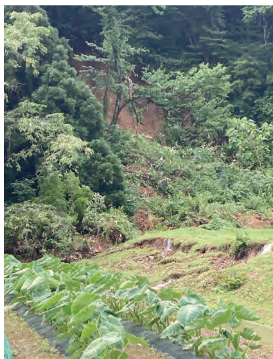
西沢地内の土砂崩落
