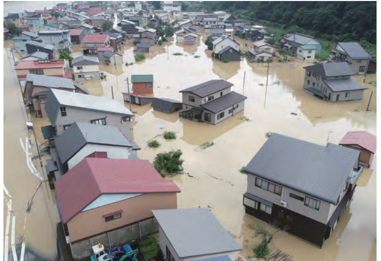
古口地区の浸水状況
