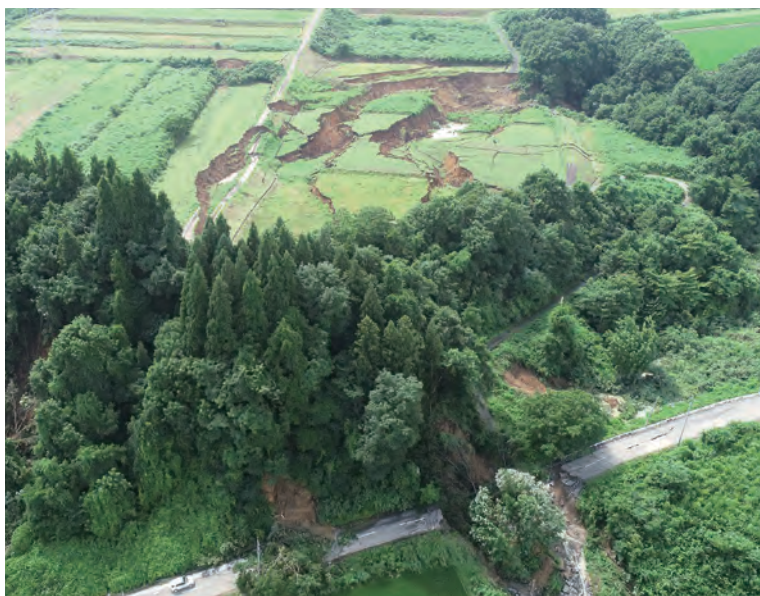
野口地内（ぼんぽ館上の）農地・土砂崩落
