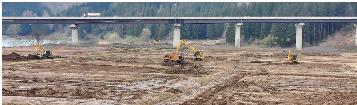
皿嶋地区災害復旧工事
