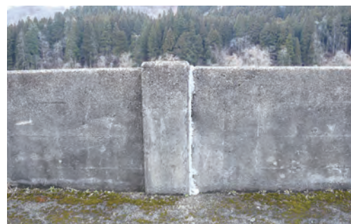
擁壁天端のパラペット
