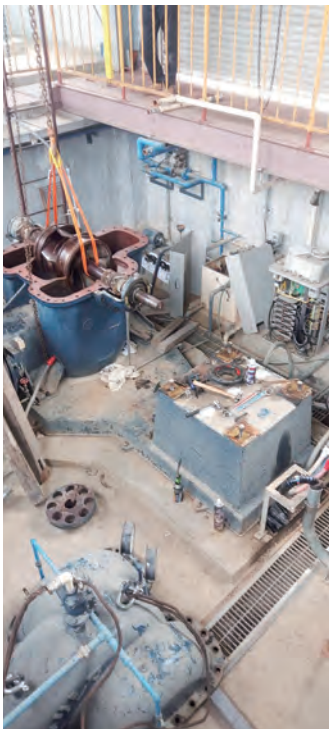
名高1段揚水機場
