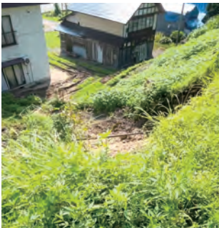
名高の土砂災害力所
