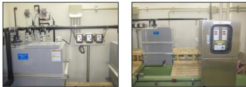
トンネルから来た水に薬を入れてマンガン砂でろ過し、水道水にします。
