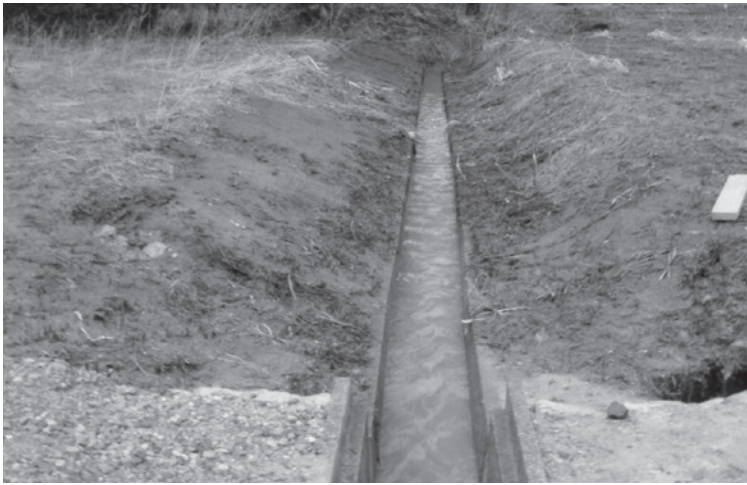
向名高地区排水路
