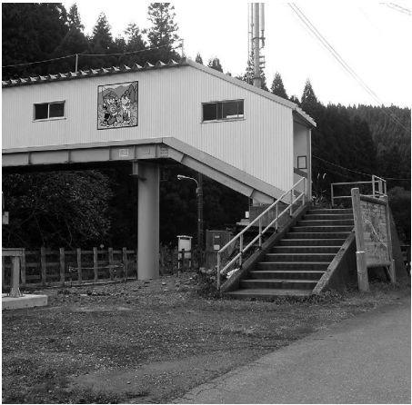
JR高屋駅歩道橋
