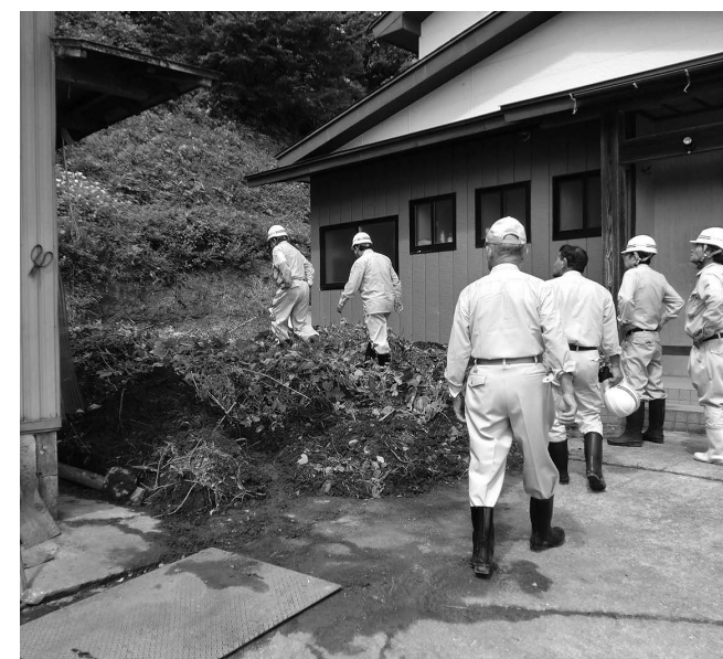
8.30 神田地内 民家法面崩落現場の確認
