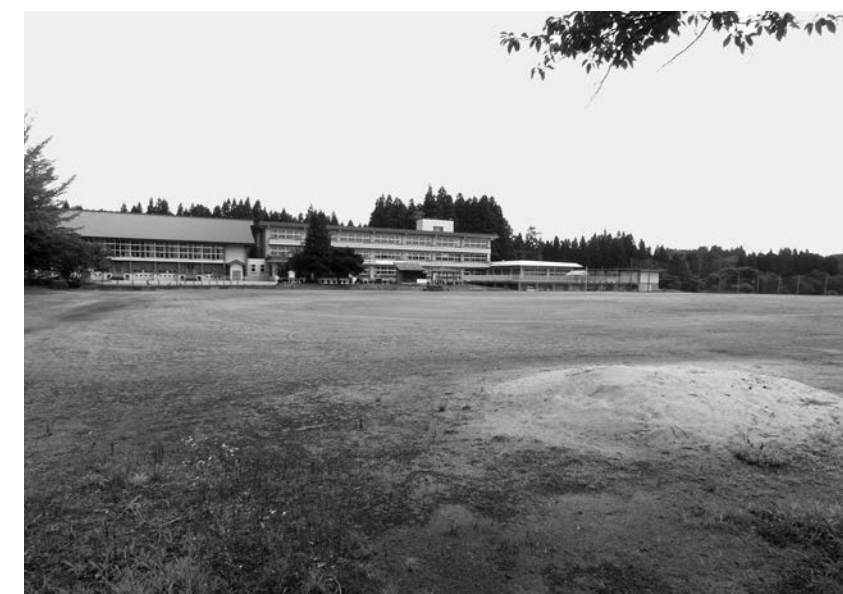
旧戸沢小学校 校舎・グラウンド
