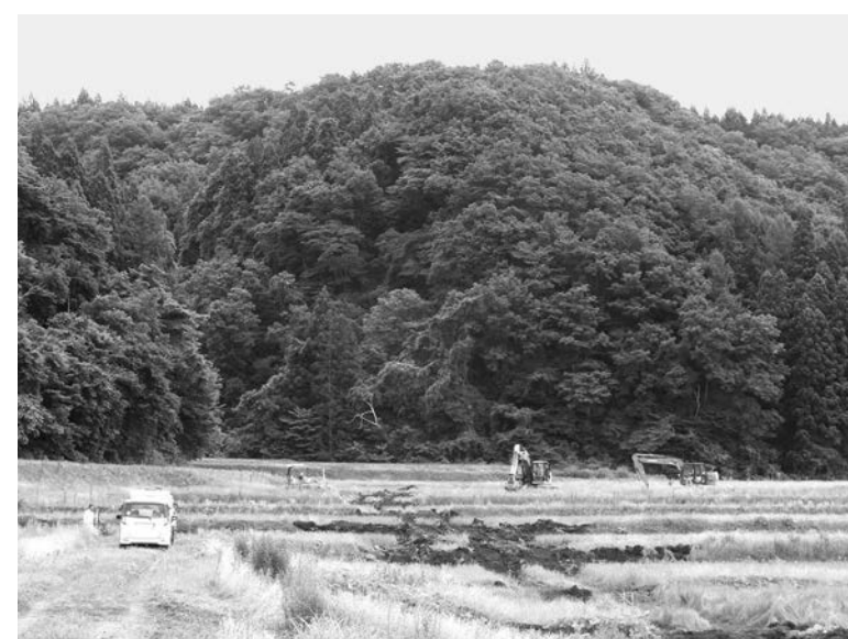
造成が始まった養豚施設用地（野口地内）
