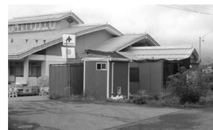
旧角川保育所内 工事用現場事務所
