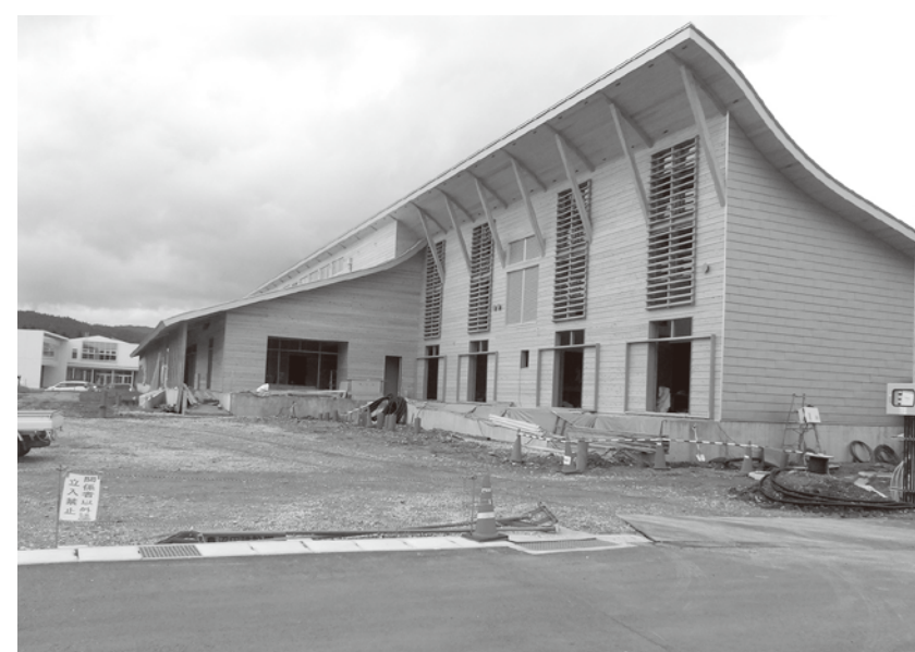
建設中の統合保育所
