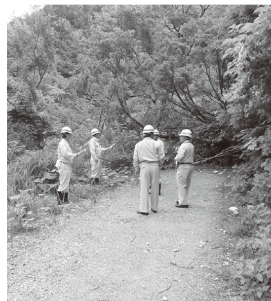
村道が埋没した災害現場
