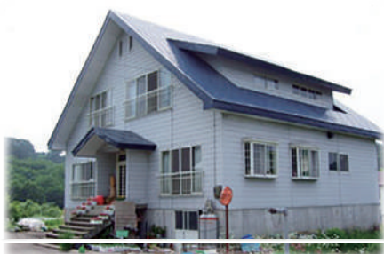
県道沿いに建つ有屋根のきれいな民宿。
