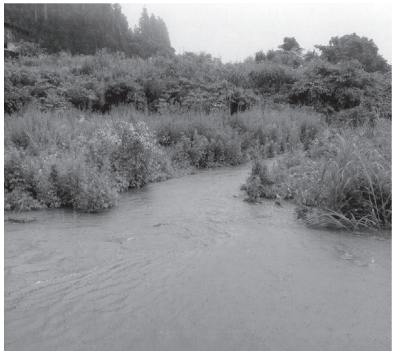
排水しきれない水路（向名高地内）
