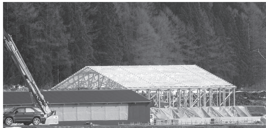
建設工事中の養豚場
