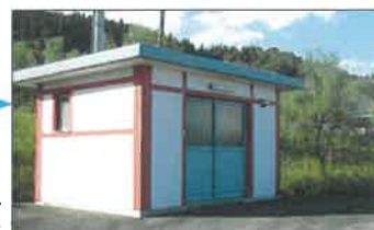
蔵岡加圧ポンプ場
