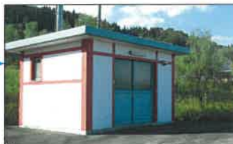
蔵岡加压ポンプ場
