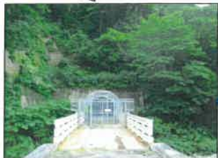
平根排水トンネル
