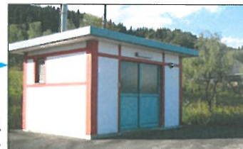
蔵岡加压ポンプ場
