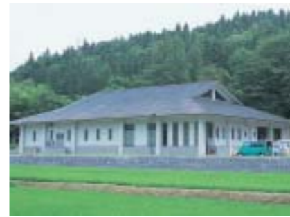
家庭からの雑排水をきれいにして川に戻す古口浄化センター
