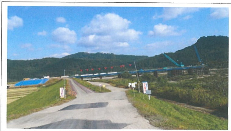
写真 7-12 地域高規格道路新庄酒田道路橋脚工事
