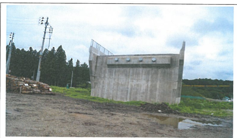
写真 7-13 地域高規格道路新庄酒田道路トンネル構造物(ボックスカルバート)敷設状況
