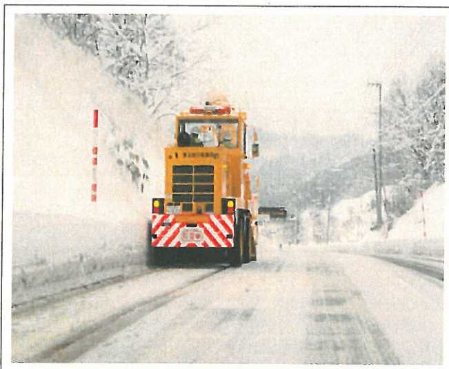
写真 8-21 道路の除雪風景写真
