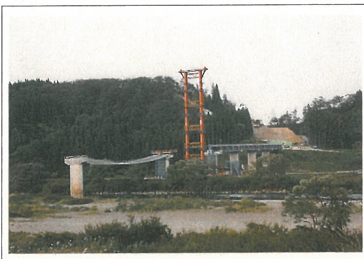
写真 7-12 地域高規格道路新庄酒田線橋脚工事
