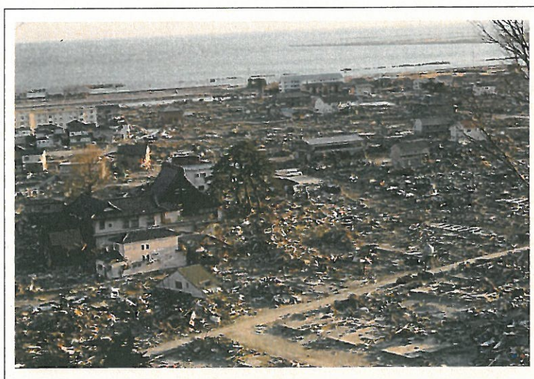
写真 7-13 東日本大震災被災風景(石巻市門脇地区)
